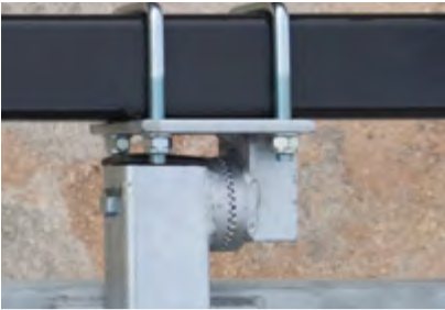
Réglage de l'inclinaison via le système de disque denté
